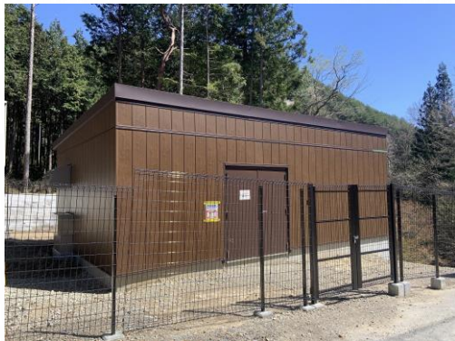
発電所の外観。周囲の景観になじむ色合いに
