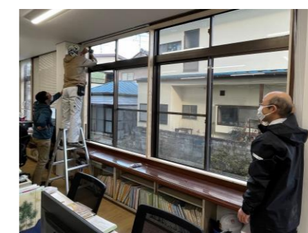
事務所の内窓をDIY設置
