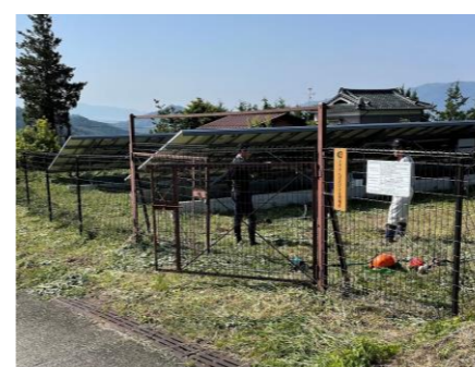
飯田山本おひさま発電所の草刈り作業
