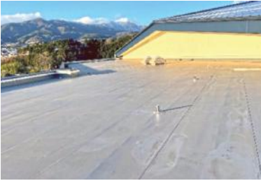
パネル設置する高森町体育館屋根
