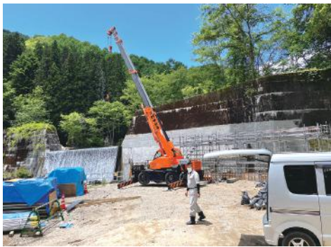
2022年1月、建設工事がスタート。飯田市内の建設会社・神稲建設(株)が施工しました。(2022年)
