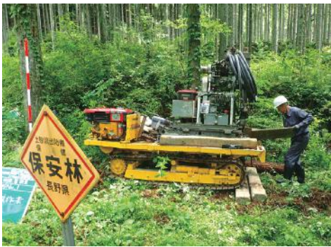
長野県の補助金を活用して詳細設計がスタート。発電所予定地の地質確認でボーリング調査を実施しました。(2020年6月)
