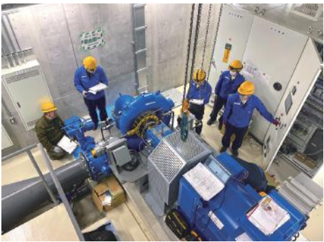
すべての工事が完了後、設備に水を通して不具合がないか等確認する試験運転を続けました。(2023年6月)
