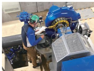
三峰川電力による定期点検
